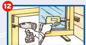
**12** Bohren Sie nun die Dübellöcher durch die Unterlegklammern / Falz des Rahmens in den Rahmen. Bohren Sie mit einem langen Steinbohrer weiter ins Mauerwerk.
