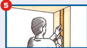
**5** Messen Sie dann die Maueröffnung für das neue Fenster und die Laibung exakt aus. Achten Sie darauf, dass zwischen Fenster und Mauer rundherum eine 10 - 25 mm breite Arbeitsfuge zum Ausschäumen / Verstopfen übrig bleibt.
