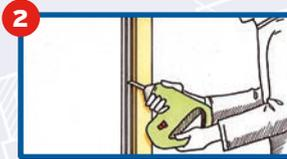
**2** Anschließend muss der Fensterrahmen in mehrere Teile zersägt werden. Hierzu verwenden Sie am Besten einen (Elektro-) Fuchsschwanz.
